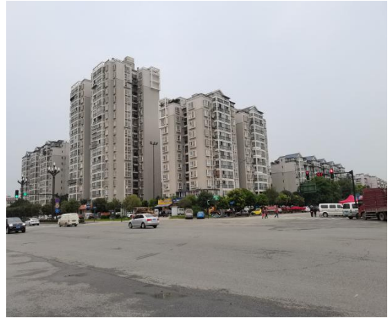
项目路面情况
