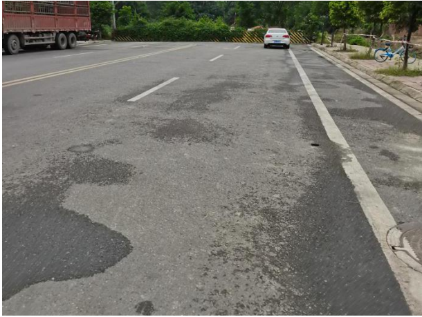
项目路面情况
